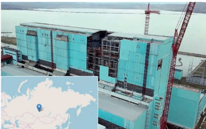
Рис. 1. Берёзовская ГРЭС. Внешний вид и расположение (источник: [4])
