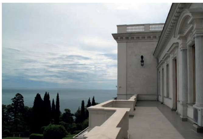
Рис. 6. Лоджия над личным подъездом императора. Фото И.Н. Слюньковой. 2015 год
