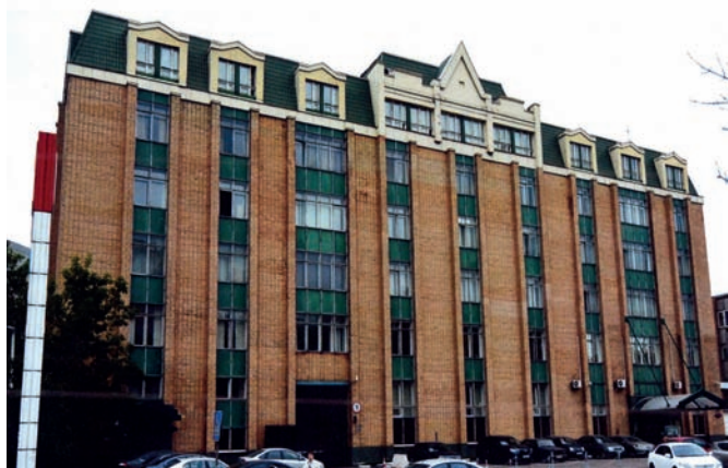
Здание института «ВНИИжелезобетон» (Москва, ул. Плеханова, 7)
