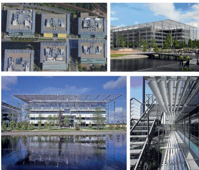
Рис. 13. Комплекс делового парка «Чизвик». Лондон. Рабочие здания-модули: вид сверху, наружные коммуникации и защитные жалюзи, виды природной рекреационной зоны с водоёмом
