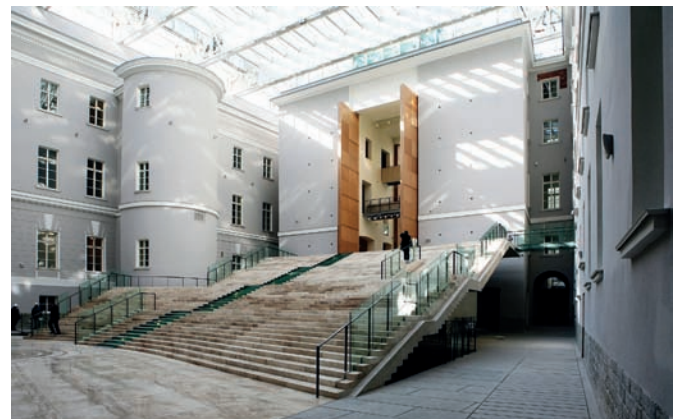
Эрмитаж. Главный штаб. Реконструкция. Академик РААСН Н.И. Явейн. Санкт-Петербург
