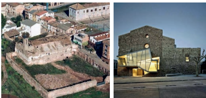
а) б) Рис. 2. Санпедор. Собор Сан Франческо: а) до реконструкции; б) западный фасад собора после приспособления под культурный центр
