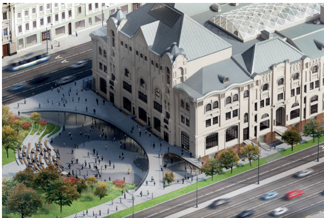
Рис. 7. Реконструкция комплекса Политехнического музея в Москве (источник: https://stroj.mos.ru/riekonstruktssiia-politiekhnichieskogho-muzieia )
