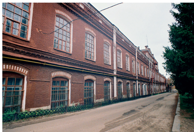
Рис. 7. Фабрика Товарищества П.Н. Грязнова. Отделочный корпус. Город Иваново-Вознесенск (сейчас город Иваново), 1893 год. Современное фото А.В. Снитко
