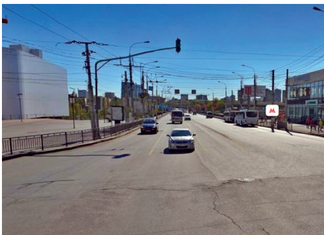
Рис. 13. Движение транспорта по проспекту им. В.И.Ленина после строительства Нулевой рокадной магистрали. Волгоград
