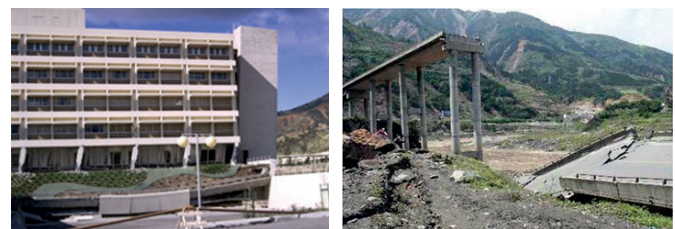
Рис. 2. Примеры разрушенных сооружений вследствие больших перемещений. Фото из открытых источников сети Интернет
