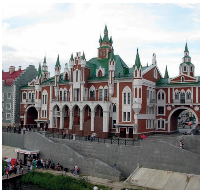
Рис. 3. Здание отдела ЗАГС на набережной Брюгге. Фото А.В. Лисицыной. 2015 год
