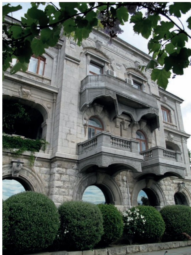
Рис. 1. Дом Фредерикса. Восточный фасад. Фото И. Слюньковой. 2015 год
