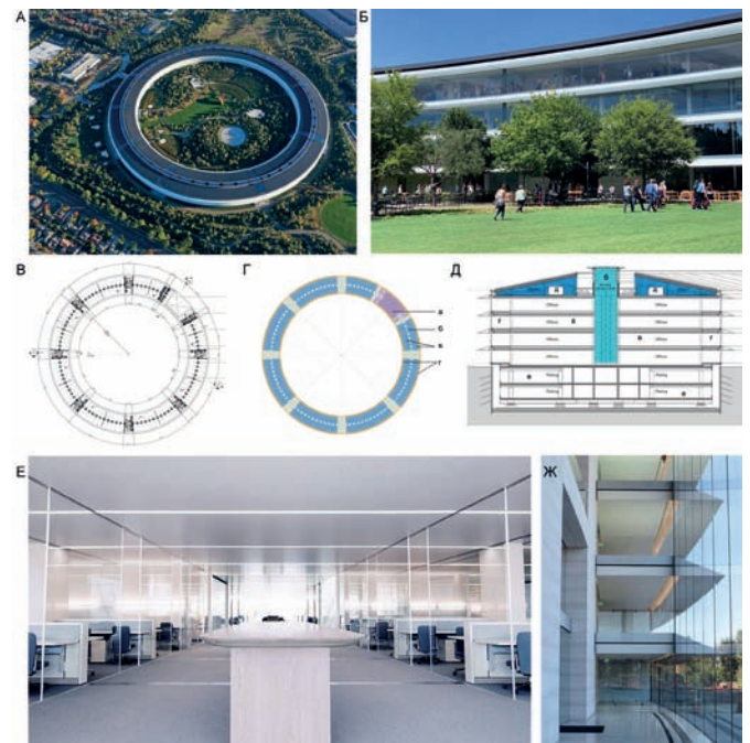
Рис. 4. Кампус Apple Park, Калифорния, США: А – вид сверху; Б – внутренний двор; В, Г – план и схема зонирования рабочего уровня; Д – схема поперечного разреза; Е – интерьеры рабочих помещений; Ж – рекреационные террасы; а – ресторан; б – вертикальные коммуникационные и инженерно-технические шахты; в – зоны рабочих мест; г – балконы – рекреационные проходы; д – инженерно-техническое оборудование; е – подземные паркинги
