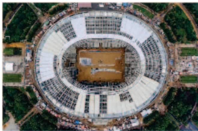
Рис. 4. Новое поликарбонатное покрытие кровли стадиона: а) общий вид; б) вид сверху
