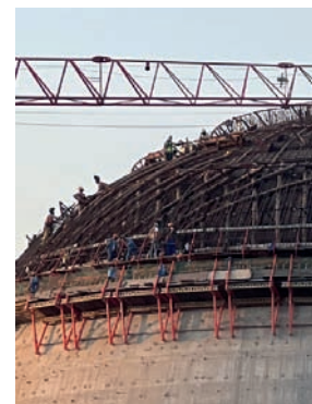
Рис. 1 2 . Примеры, элементов конструкций с закрытой бетонной поверхностью для которых возможно использование разрабатываемого метода контроля сплошности бетона: а) использование трубобетонных конструкций в гражданском строительстве; б) стальной модуль стены с последующей заливкой бетоном. АЭС «Вогтль», блок № 3, 4. США. Дата окончания строительства – 2023 год; в) вид изнутри модуля сталежелезобетонной стены АЭС Саньмень. Китай. Дата постройки – 2018 год (источник: Design Guide 32: Modular Steel-Plate Composite Walls for Safety-Related Nuclear Facilities), г) устройство стальных труб системы предварительного напряжения в защитных атомных оболочках реакторного отделения. Фото авторов статьи
