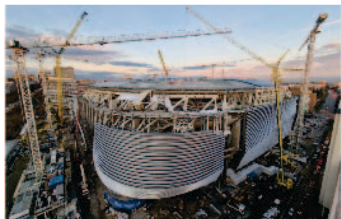
Рис. 22. Монтаж стальных ламелей по направляющим
