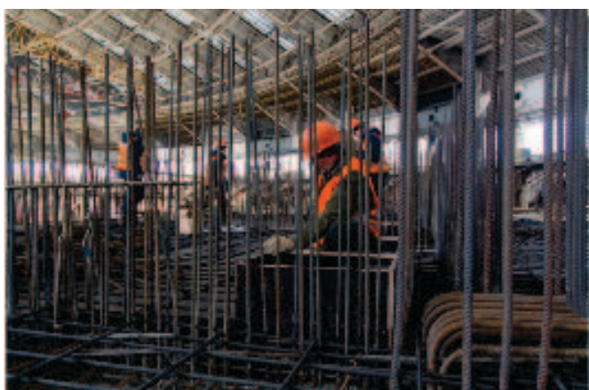
Рис. 10. Монтаж арматуры при устройстве чаши стадиона
