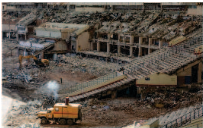
Рис. 7. Работы по демонтажу: а) старого каркаса трибун; б) конструкций подтрибунных помещений
