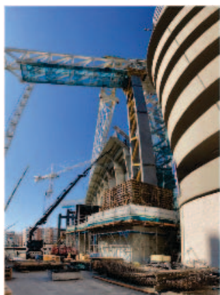
Рис. 17. Монтаж новой северо-восточной башни вокруг опоры под конструкцию крыши
