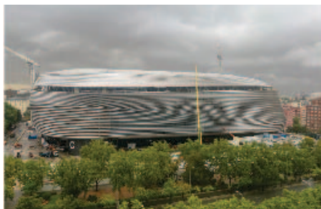
Рис. 23. Фасад стадиона после завершения монтажа металлической оболочки
