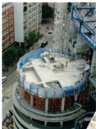
Рис. 18. Демонтаж верхнего яруса эвакуационной башни А с восточной стороны
