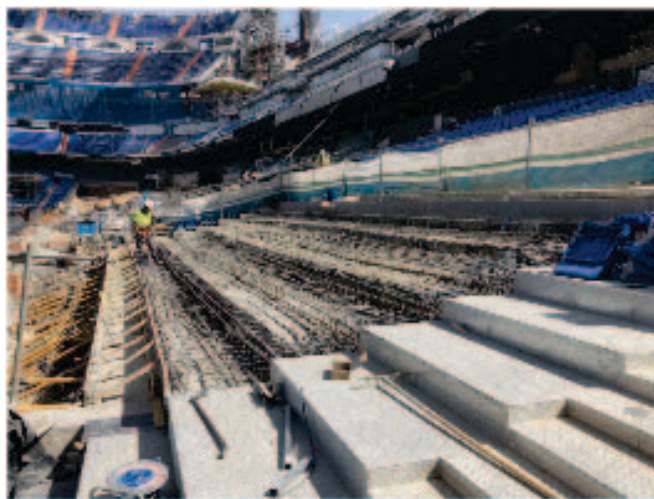
Рис. 31. Подготовка к бетонированию ступеней восточной трибуны нижнего сектора
