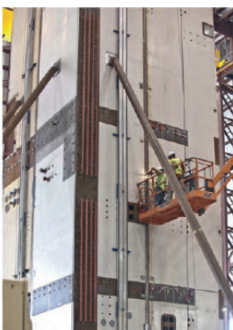
Рис. 1 2 . Примеры, элементов конструкций с закрытой бетонной поверхностью для которых возможно использование разрабатываемого метода контроля сплошности бетона: а) использование трубобетонных конструкций в гражданском строительстве; б) стальной модуль стены с последующей заливкой бетоном. АЭС «Вогтль», блок № 3, 4. США. Дата окончания строительства – 2023 год; в) вид изнутри модуля сталежелезобетонной стены АЭС Саньмень. Китай. Дата постройки – 2018 год (источник: Design Guide 32: Modular Steel-Plate Composite Walls for Safety-Related Nuclear Facilities), г) устройство стальных труб системы предварительного напряжения в защитных атомных оболочках реакторного отделения. Фото авторов статьи
