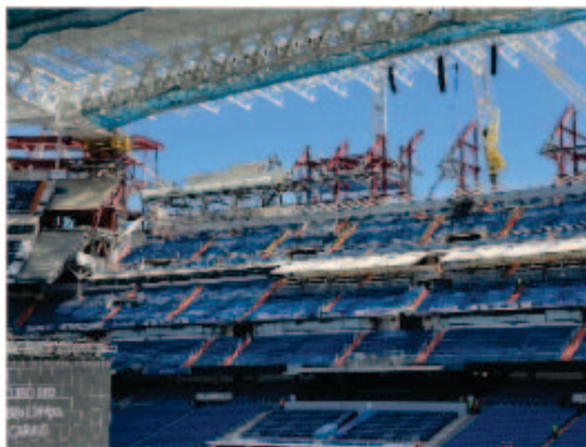
а) Рис. 29. Устройство новых трибун: а) демонтаж верхнего яруса восточной трибуны; б) новые трибуны на месте демонтированных
