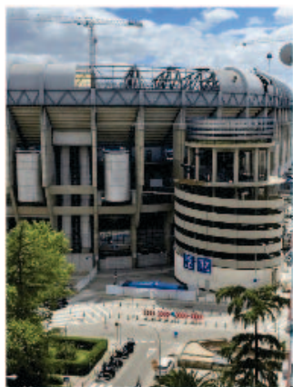
Рис. 19. Процесс демонтажа старой крыши
