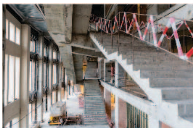
Рис. 12. Устройство каскадных пешеходных лестниц
