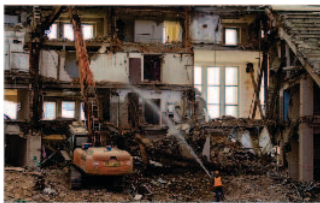
Рис. 7. Работы по демонтажу: а) старого каркаса трибун; б) конструкций подтрибунных помещений
