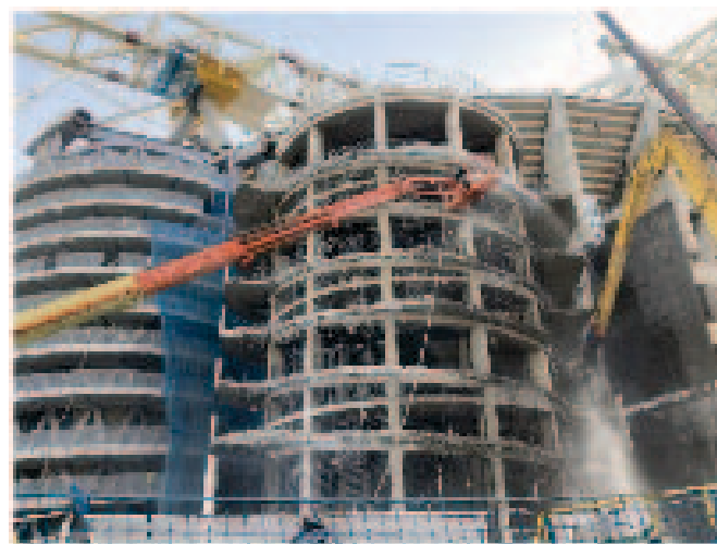
Рис. 15. Демонтаж старой эвакуационной башни В
