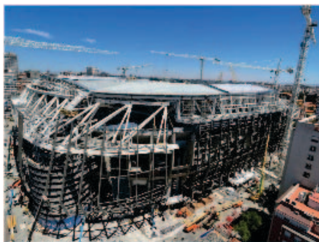
Рис. 25. Установка направляющих по периметру стадиона
