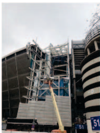
Рис. 16. Демонтаж северо-восточной башни
