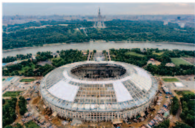
Рис. 4. Новое поликарбонатное покрытие кровли стадиона: а) общий вид; б) вид сверху
