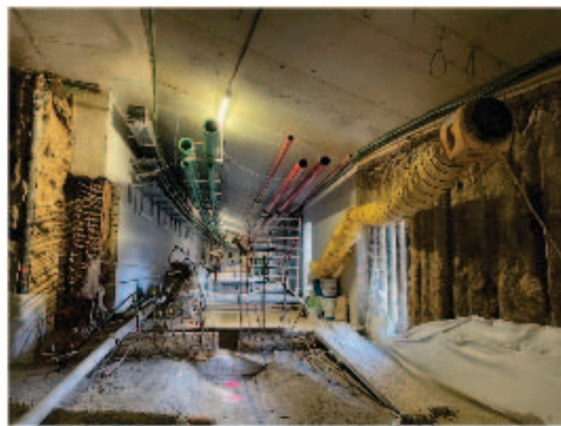
Рис. 32. Логистический туннель: а) устройство подвода к футбольному полю; б) прокладка коммуникаций
