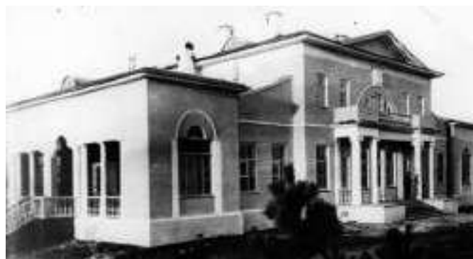
Дом помещика Селиванова. Архитектор Н.А. Круглов. Рязанская губерния. Фото 1915 года
