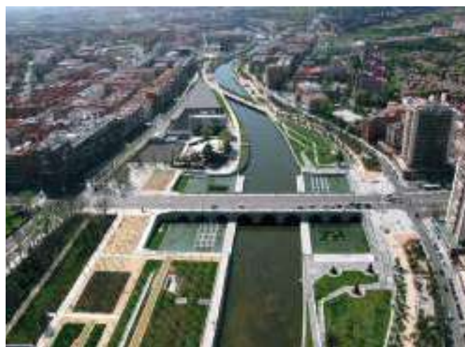
Рис. 3. Вид набережной реки Мансанарес после переноса в подземное пространство автомагистрали М30
