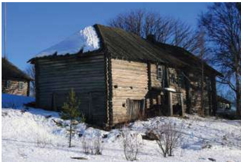
Дом-двор Гоголева в деревне Канзанаволок Пудожского района Карелии. На переднем плане – задняя хозяйственная половина дома с воротами и заложенным проёмом, где были встроены хлева. Фото А.Б. Бодэ. 2015 год
