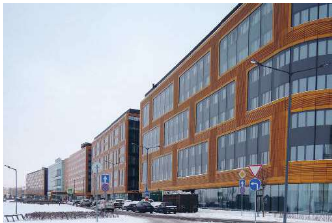
МВЦ «ЭкспоФорум». Первая линия застройки, выходящая к Петербургскому шоссе. Фото Ю.А. Никитина
