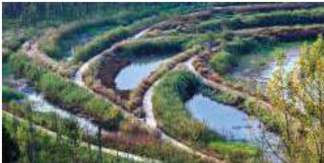
Рис 2. Парк «Минху Ветланд» (Minghu Wetland Park, ландшафт. компания Turinscape, Китай, 2013 год). Причина адаптации – наводнения и паводки (условия). Основное средство адаптации – система террас (ландшафтные компоненты)
