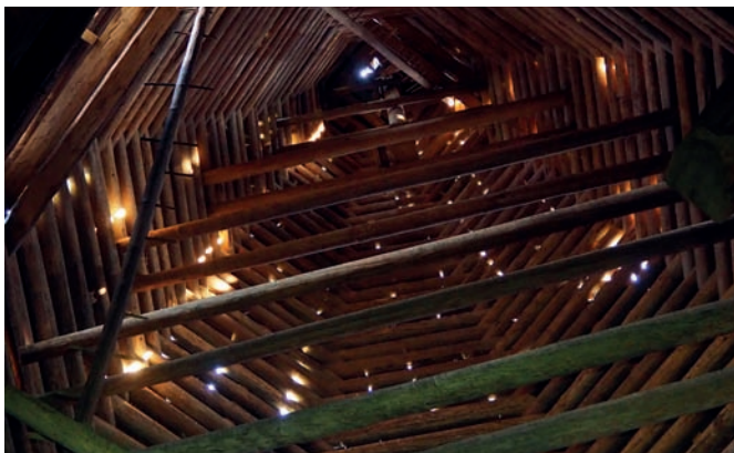
Рис. 5. Конструкции рубленого шатра Вознесенской церкви. Фото А.Б. Бодэ
