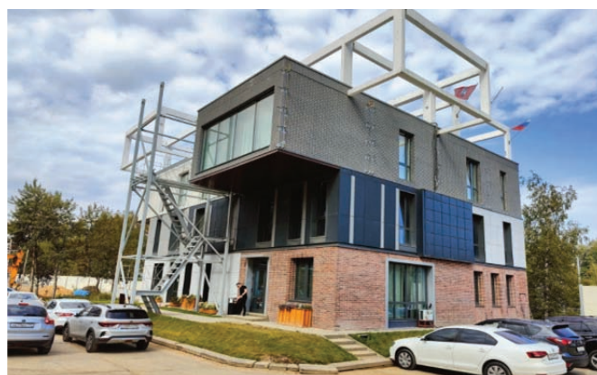
Рис. 4. Пример компоновки здания из крупногабаритных железобетонных модулей
