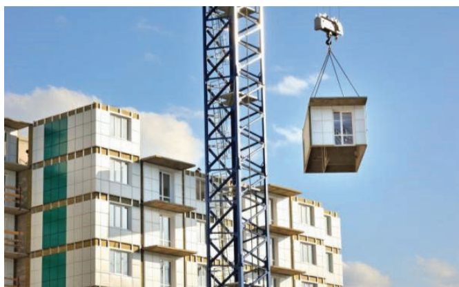
Рис. 3. Монтаж железобетонного модуля типа «колпак»
