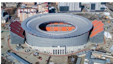
Рис. 7. Стадион «Газпром-арена». Санкт-Петербург. 2016 год
