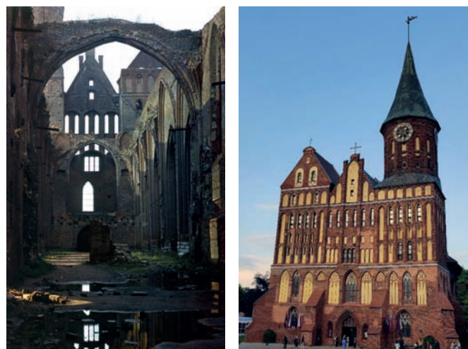
Рис. 11. Калининград. Кафедральный собор: а) руины. Фото 1989 года; б) общий вид. Фото А.В. Саенко. 2024 год
