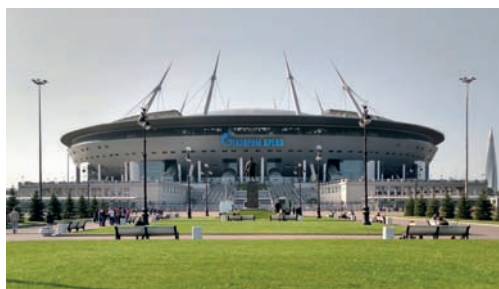
Рис. 10. Стадион «Центральный». Екатеринбург. Реконструкция к ЧМ-2018
