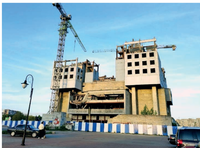
Рис. 12. Завершение демонтажа Дома Советов в Калининграде. Май 2024 года. Фото А.В. Саенко
