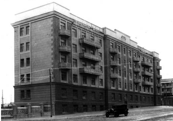
Рис. 5. Жилой дом НКВД на ул. Пензенской. Архитектор В. Кочедамов. 1935 год (источник: ГНИМА им. А.В. Щусева, НВФ 279-20)
