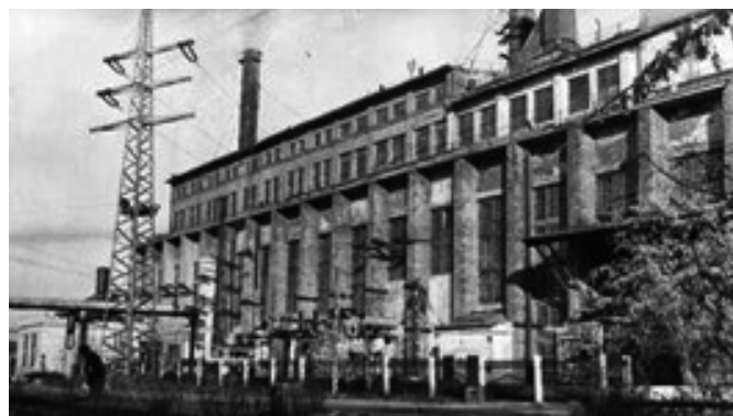
Рис. 8. Электростанция «Красный Маяк». 1932 год. Архитектор-художник И.В. Рянгин. Фото из открытых источников сети Интернет
