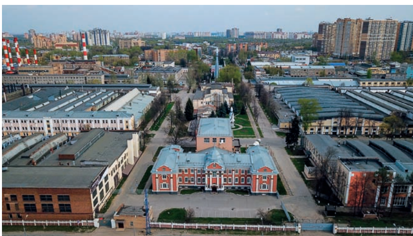
Рис. 1. Королёв. Комплекс зданий РКК «Энергия». На переднем плане в центре – заводу управления бывшего Московского оружейного завода. Архитектор А.А. Галиевский. 1923 год. Фото И.А. Гришина. 2017 год
