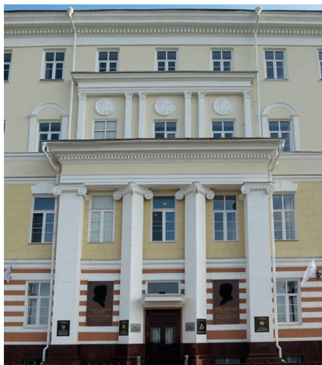
Рис. 6. Реконструкция здания радиотехникума на Верхневолжской набережной, 5. Фрагмент фасада. 1948–1949 годы
