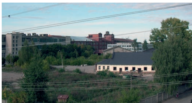
Рис. 3. Внедрение новых зданий конца XX века в исторический промышленный комплекс. Город Фурманов Ивановской области. Фабрика № 1 (бывшая фабрика Скворцова). Фото автора
