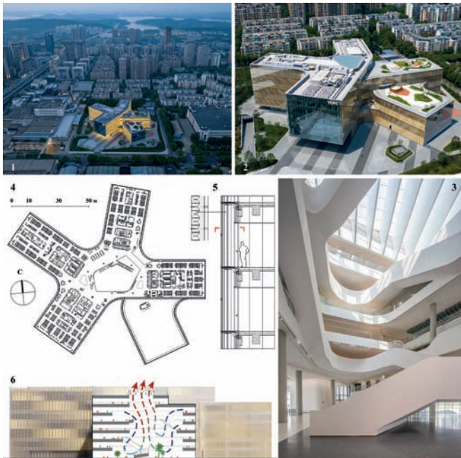
Рис. 6. Штаб-квартира фирмы «YOFC». Ухань: 1, 2, 3 – виды здания и интерьер атриума; 4 – план рабочего этажа (6-ой уровень); 5 – деталь «умного фасада»; 6 – схема естественной вентиляции атриума
