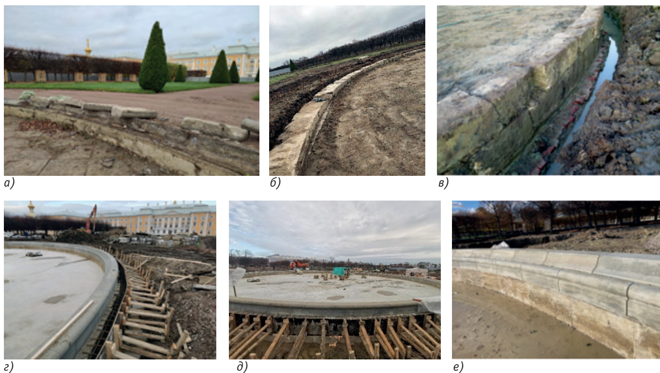
Рис. 5. Фонтан «Дубовый» в период реставрации. 2020–2023 годы (источник: архив службы реставрации, реконструкции и капитального ремонта ГМЗ «Петергоф»): а, б) кордонный камень из доломита, мраморные плиты мощения дна и стеновые блоки из известняка (деструкция, каверны, трещины, расслоение). 2020 год; в) фундамент из кирпичной кладки под стеной фонтана из известняковых блоков. 2020 год; г, д) вид пруда с фонтаном «Дубовый» в период реставрации. 2022 год; е) чаша пруда с фонтаном «Дубовый» после реставрации. 2023 год
