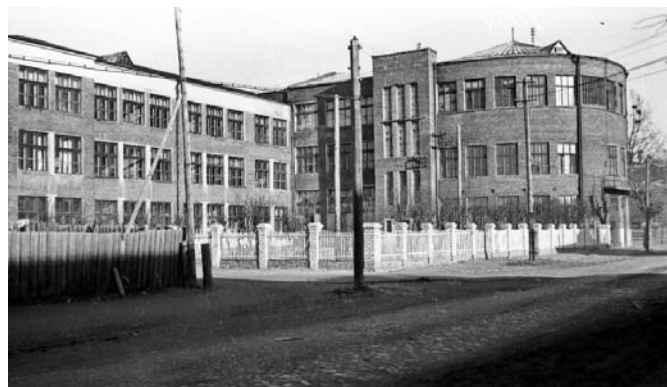
Рис. 5. Город Шуя Ивановской области. Школа ФЗУ на 1-й Нагорной улице. 1930-е годы (источник: [8])
