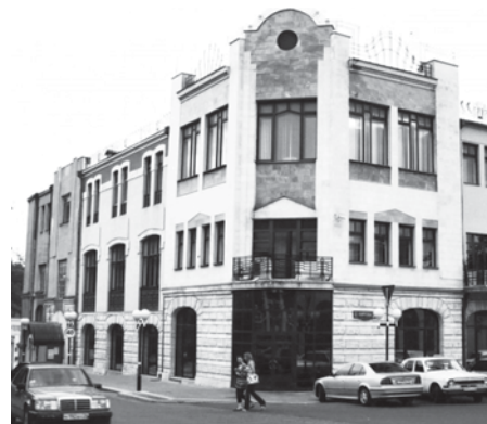
Здание Госбанка. Кисловодск. 1923–1924 годы
