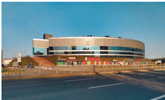
Рис. 24. Санкт-Петербург. Ледовый дворец на проспекте Большевиков
