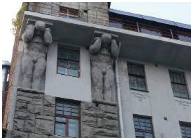
Рис. 15. Атланты, поддерживающие монолитную плиту балкона под мансардной частью крыши
