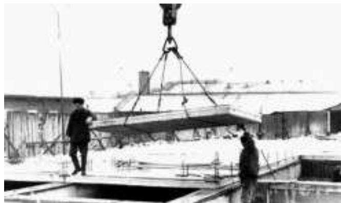
Рис. 4. Технология быстрого монтажа на основе мелкоэлементной системы «Сокол». 21-й ДОЗ. Монтаж панелей перекрытий. Узлы – стальные фигурные пластины. Город Вологда
