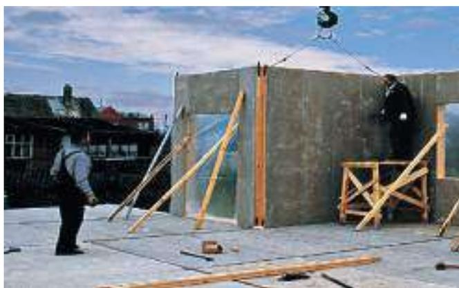
Рис. 3. Быстрый монтаж стен и перегородок. Масса 120–250 кг, дерево-стальной каркас панелей, обшивки – цементно-стружечная плита, ориентированно-стружечная плита
