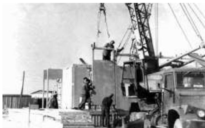
Рис. 5. Монтаж панелей стен экспериментального физкультурно-оздоровительного комплекса. Город Вологда
