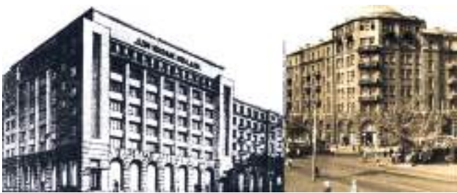
Рис. 21. Жилой дом «Литерный» для сотрудников ЮЖД. Первая и вторая очереди строительства. 1925–1936 годы
