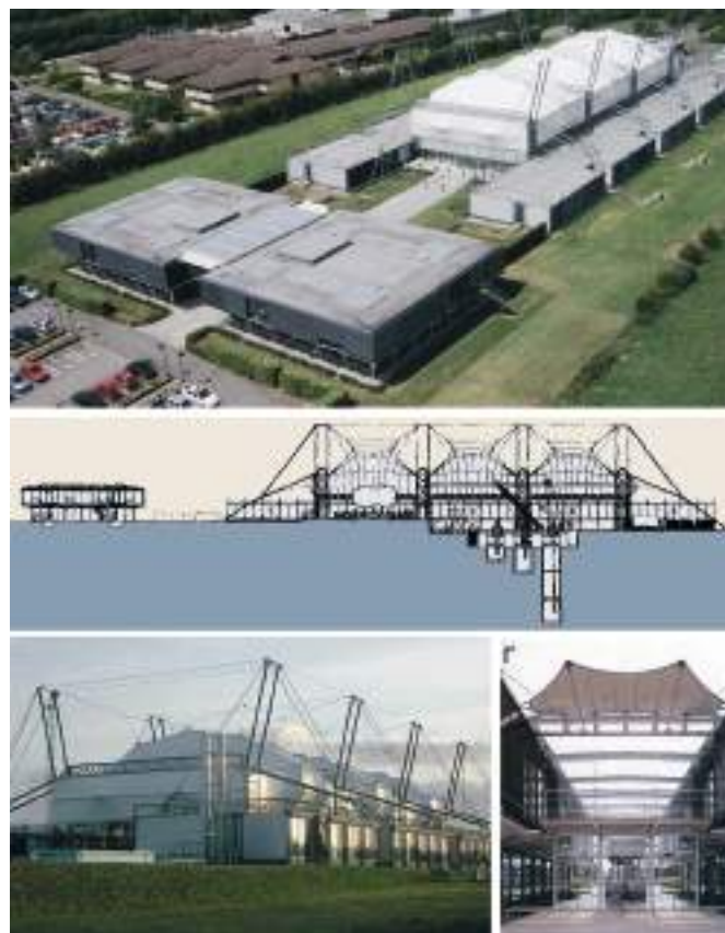
Рис. 6. Кембридж. Западная территория Университета. Экспериментально-технологический центр «Шлюмбергер Кембридж Ресёрч» («Schlumberger Cambridge Research»). Вид сверху, разрез, виды застройки
