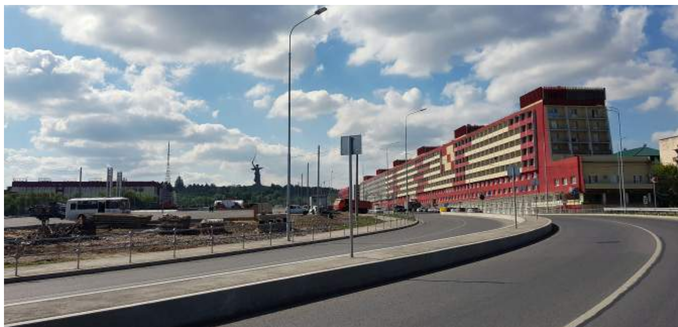
Рис. 9. Примыкание рокадной дороги к проспекту Ленина в одном уровне. В перспективе – ансамбль на Мамаевом кургане. Фото 2018 года
