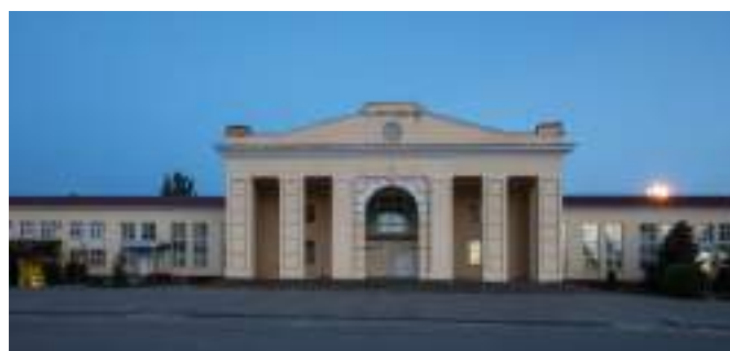
Рис. 11. Старое здание аэропорта. Волгоград
