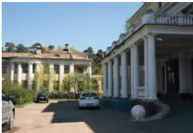
Рис. 17. Современное состояние. Вид от центрального корпуса на хирургический павильон. Фото автора. 2015 год
