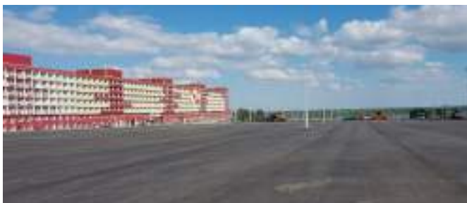
Рис. 16. Строительство автопарковки на месте предполагавшейся эспланады Мамаева кургана. Фото 2018 года
