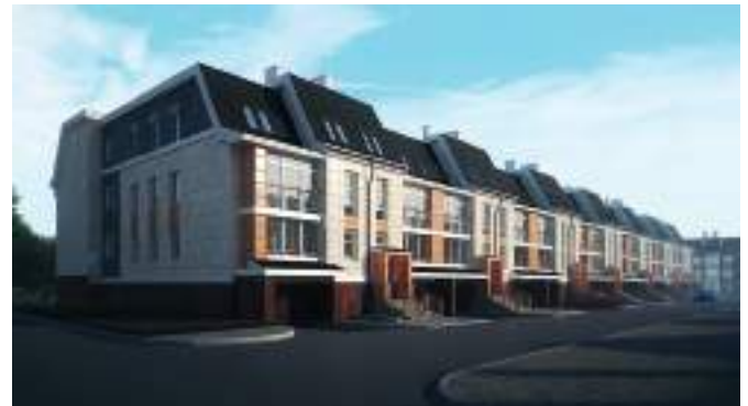
Рис. 4. Жилой комплекс бизнес-класса на улице Р. Люксембург, Заволжский район, Тверь. Фрагмент застройки таунхаусами (источник: интернет-портал «ЦИАН» <tver.cian.ru>)
