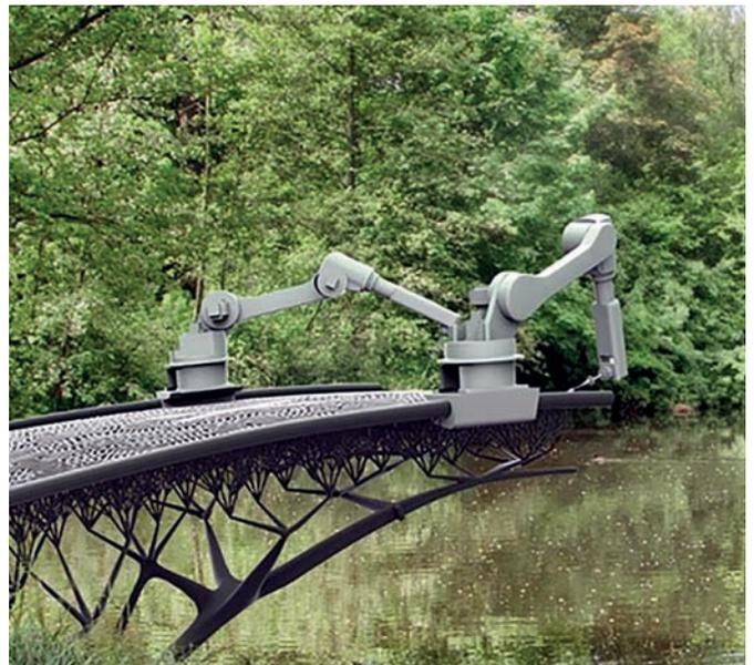
Рис. 22. Стальной мост в Голландии, возводимый с использованием аддитивных технологий
