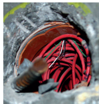
Рис. 12. Закладная деталь с кабелями тензометров, вскрытая после демонтажа опалубки стены КФ
