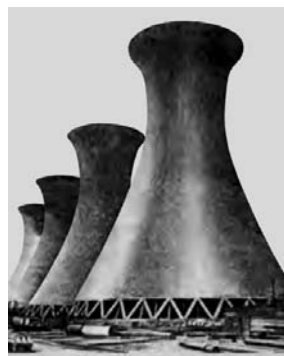
Рис. 4. Комплекс гиперboloидных башенных градирен в Хенсбруке (источник: [1])
