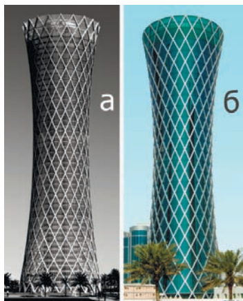
Рис. 10. Офисное здание «Торнадо Тауэр» (Tornado Tower). Катар [4]
