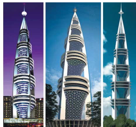
Рис. 27. Композиционное моделирование многоярусных/многозвенных составных структур-гирлянд произвольного очертания с использованием отсеков поверхности однополостного гиперболоида. Разработки и рисунки А. Коротича
