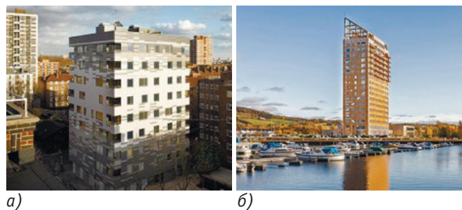
Рис. 20. Высотные деревянные здания: а) «фанерный небоскрёб». Лондон; б) многофункциональное 18-этажное здание в Брумунддале. Норвегия
