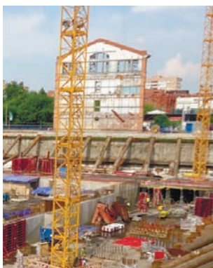
Рис. 15. Интеграция фасада исторического здания в один из корпусов жилого комплекса «Садовые кварталы» (квартал 3). Москва
