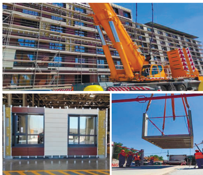
Рис. 7. Монтаж железобетонных крупногабаритных модулей (КГМ) «МонАрх»
