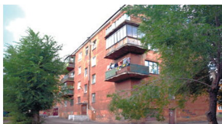
Рис. 1 2 . Жилой дом в Магнитогорске. Архитектор С.Е. Чернышёв. 1930 год
