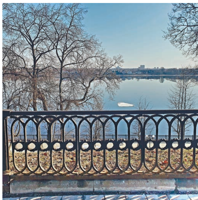
Рис. 2. Историческая чугунная решётка ограждения набережной Волги. Ярославль. 1830 год. Фотография автора
