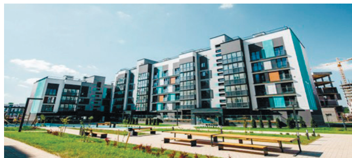
Рис. 12. Здания системы серии Б1.020.1-7. Минск, район Новая Боровая
