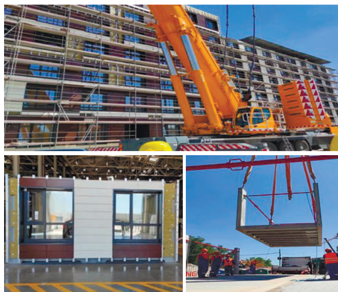
Рис. 7. Монтаж железобетонных крупногабаритных модулей (КГМ) «МонАрх»
