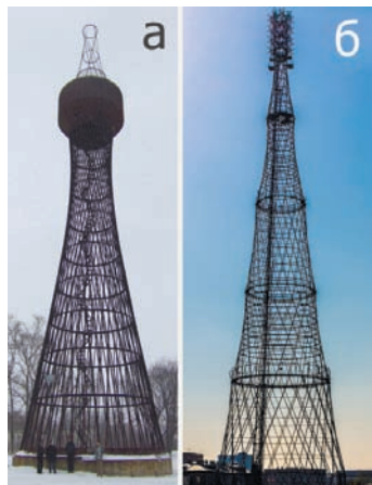
Рис. 2. Советский авангард. Решётчатые башни В.Г. Шухова как наиболее ранний пример использования формы однополостного гиперboloида в современной архитектуре: а) водонапорная башня в селе Полибине. 1896 год; б) радиобашня в Москве. 1922 год
